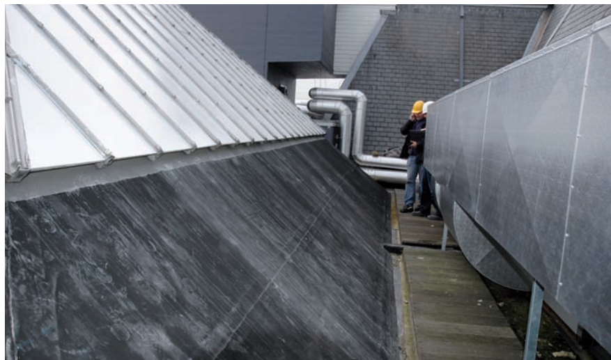
Onder de glasschilden zijn de leien vervangen door EPDM-dakbanen.
