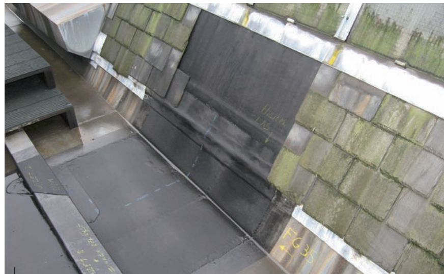
Proefstuk met EPDM in de goot
