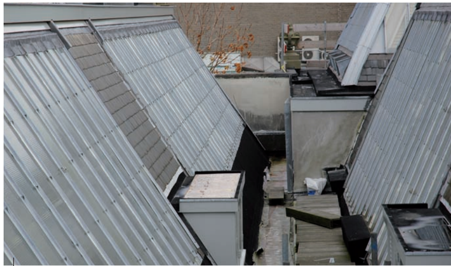
De kleine platte dakvlakken worden ook bekleed met EPDM-dakbanen.
