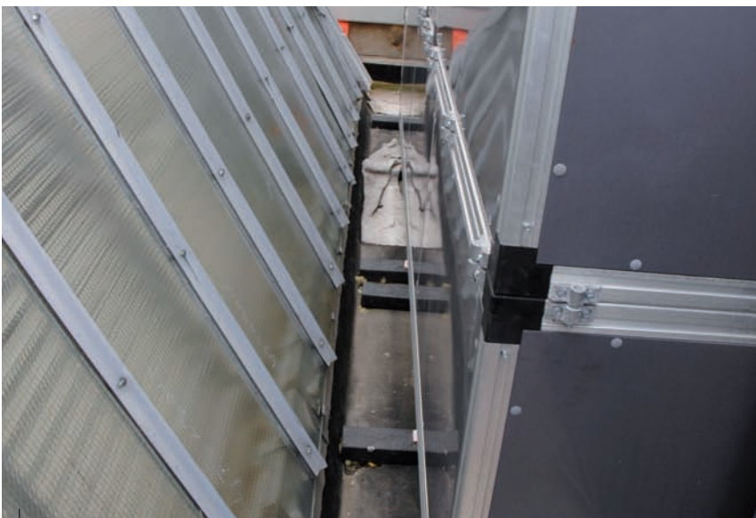
De beperkte ruimte wordt op sommige plaatsen nog minder.
