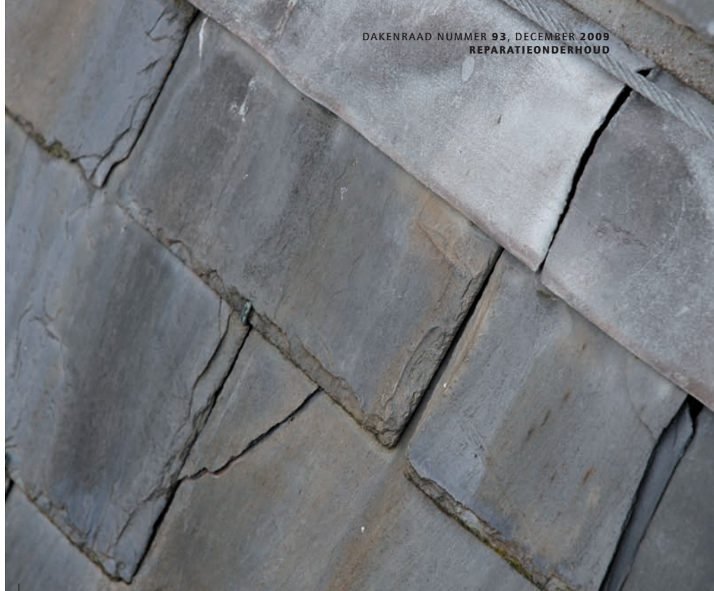
De conditie van leien en loodslabben is matig.
